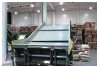
Sistema de recepción de sacos
