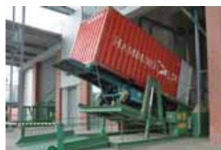
Recepción de productos a granel del contenedor
