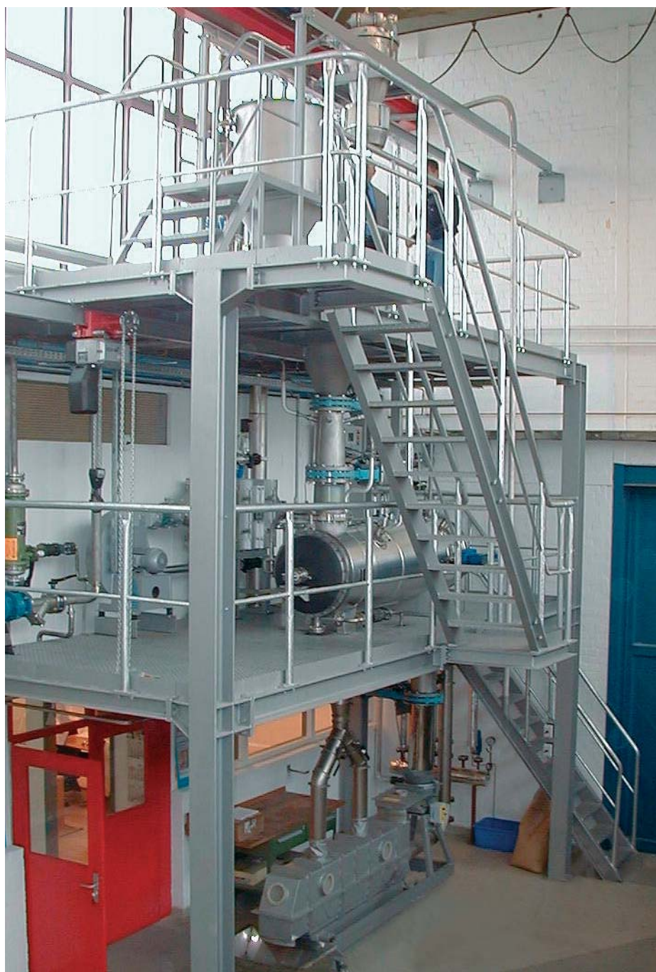
Planta hidrotérmica de cocción en la planta piloto de KAHL, Reinbek
