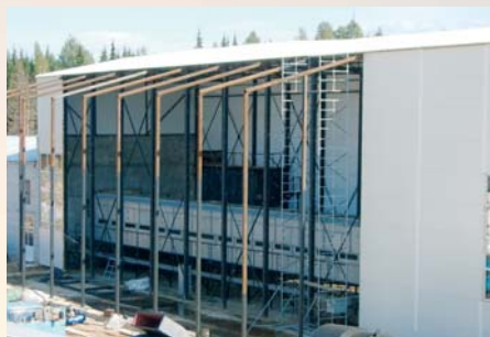
Secador de cinta textil en la fase de montaje
